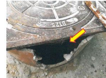
Fot. 4 Taras zewnętrzny – uszkodzenia płyty, brak warstwy hydroizolacji
