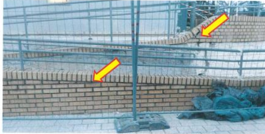
Fot. 8 Bariery ochronne – pęknięcie oraz wykwyty na murkach
