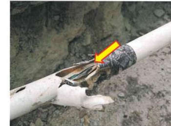
Fot. 5 Taras zewnętrzny – uszkodzenia przewodów elektrycznych
