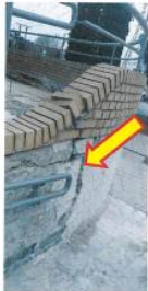
Fot. 9 Bariery ochronne – pęknięcie ściany wraz z murkiem
