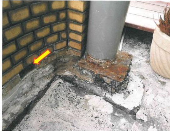
Fot. 18 Bariery ochronne – uszkodzenie cegieł
