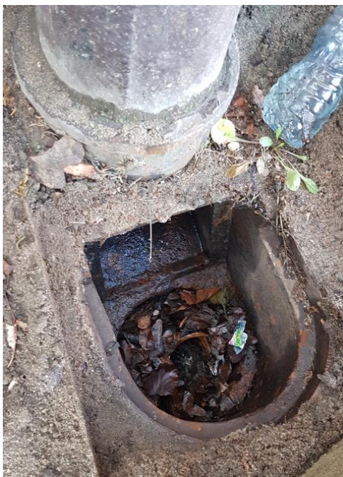
Czyszczak rury spustowej.
