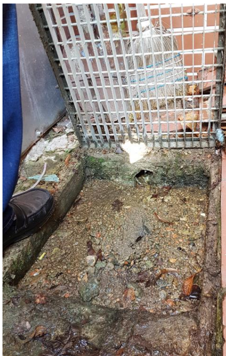
Osadnik z odpływem przed wejściem do kotłowni.
